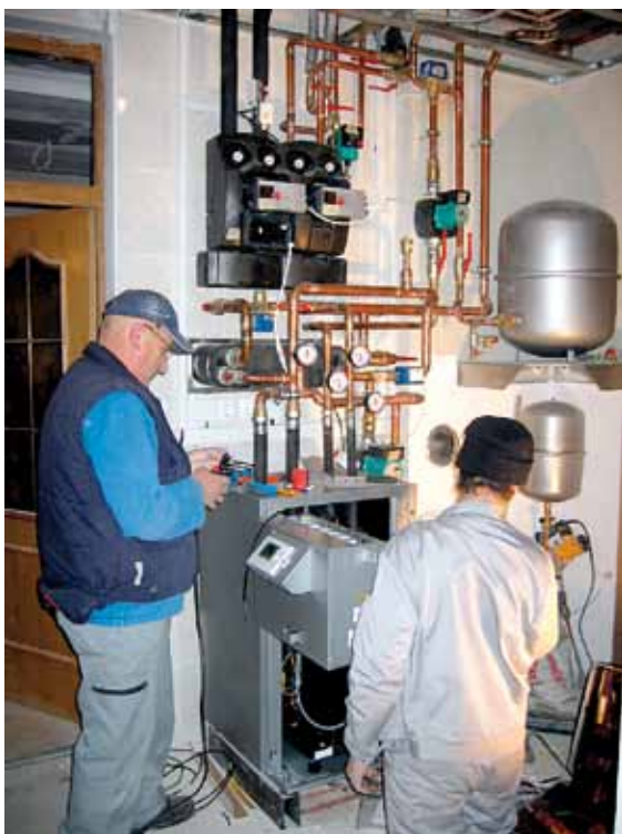
Slika 1 Povezava toplotne črpalke s pasivnim hlajenjem
